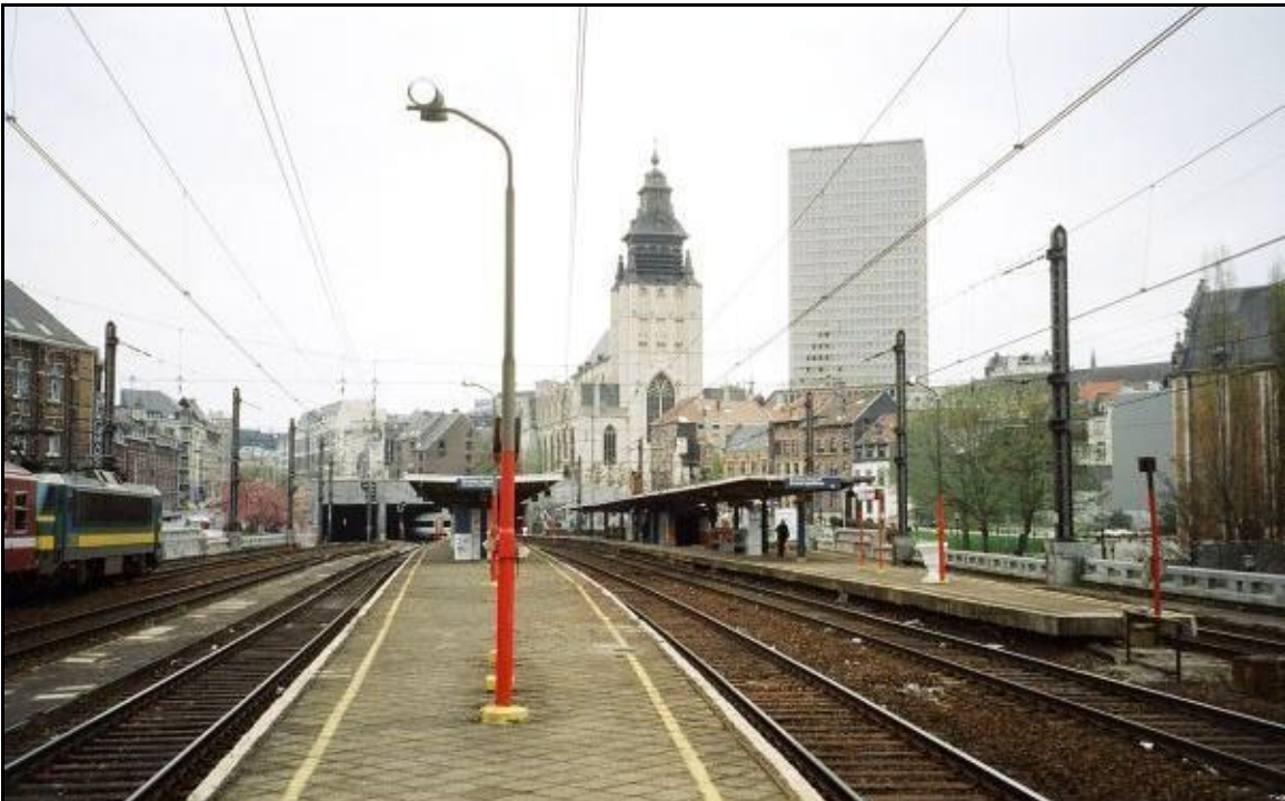
Station Brussel-Kapellekerk (vooraan) met de prachtige 12 de -eeuwse Kapellekerk en de tunnel van de Noord-Zuid Verbinding (achteraan). Een deeltje van het college is zichtbaar ter hoogte van de trein, links.
